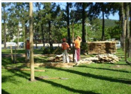
Início da obra, 05 de janeiro.
